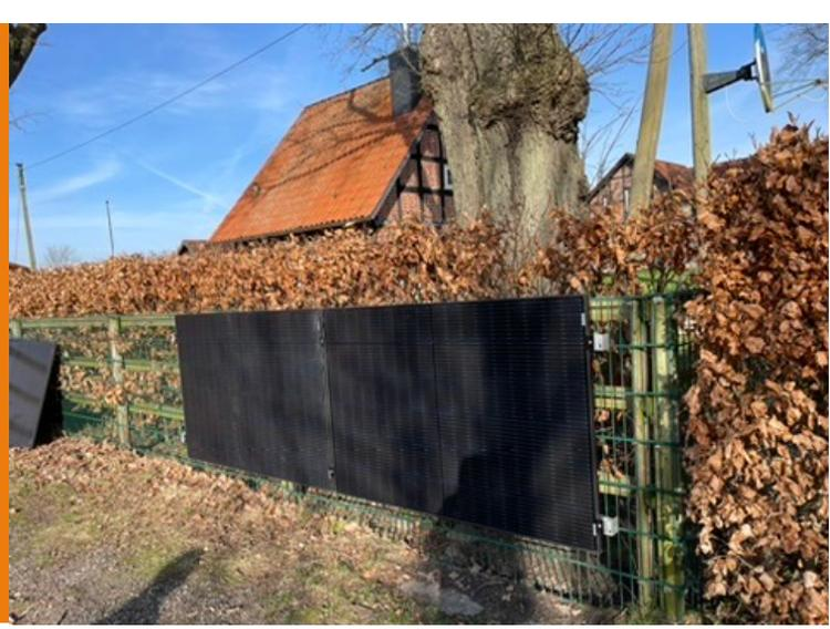
Die Installation von Solarzäunen bietet eine interessante Ergänzung zu traditionellen Photovoltaikanlagen auf Dächern. Durch die vertikale Integration der Module mit einem Winkel von 90 Grad ergeben sich spezifische Dynamiken in der Stromerzeugung, insbesondere in Bezug auf die Energieausbeute über das Jahr verteilt. In diesem Beitrag beleuchten wir die finanziellen Aspekte eines Solarzauns und analysieren, wie sich die Ausrichtung auf die Rentabilität auswirkt.
